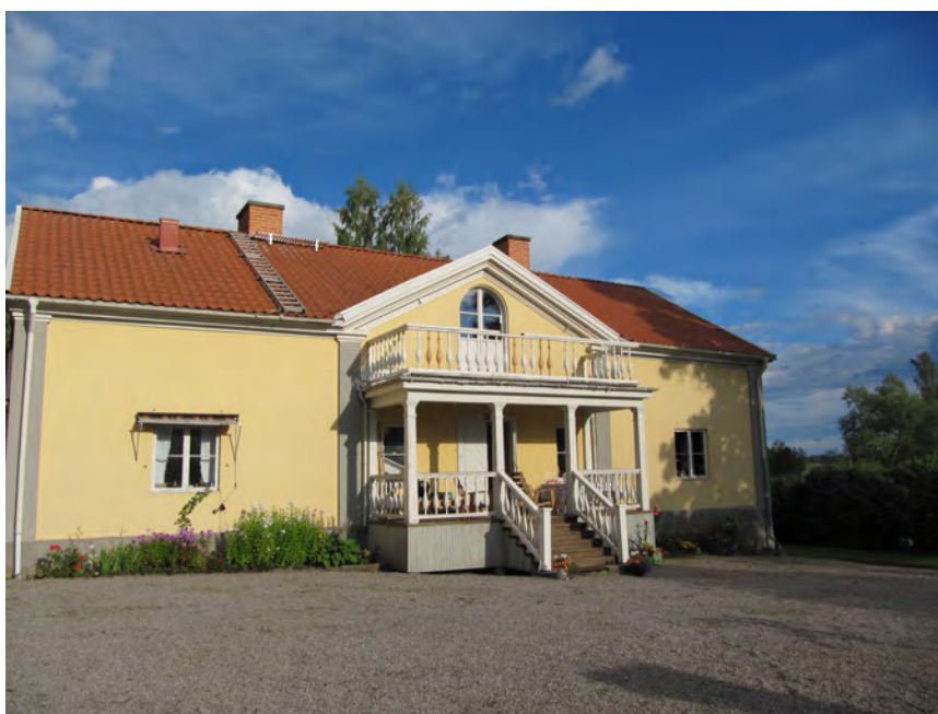
Prästgårdens corps-de-logi byggt 1809
